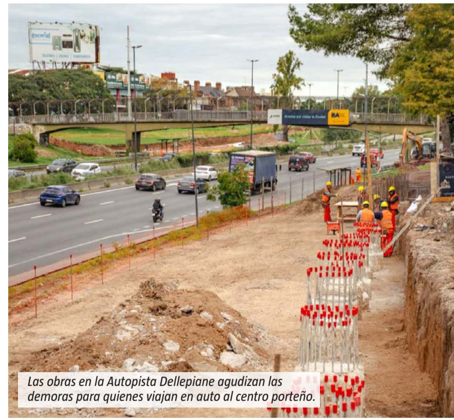
Las obras en la Autopista Dellepiane agudizan las demoras para quienes viajan en auto al centro porteño.
